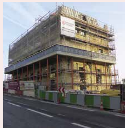
Le chantier du pavillon Lescœur rue Dailly.
