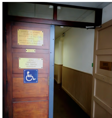
Entrée dédiée aux personnes en situation de handicap à l'hôtel de ville.
