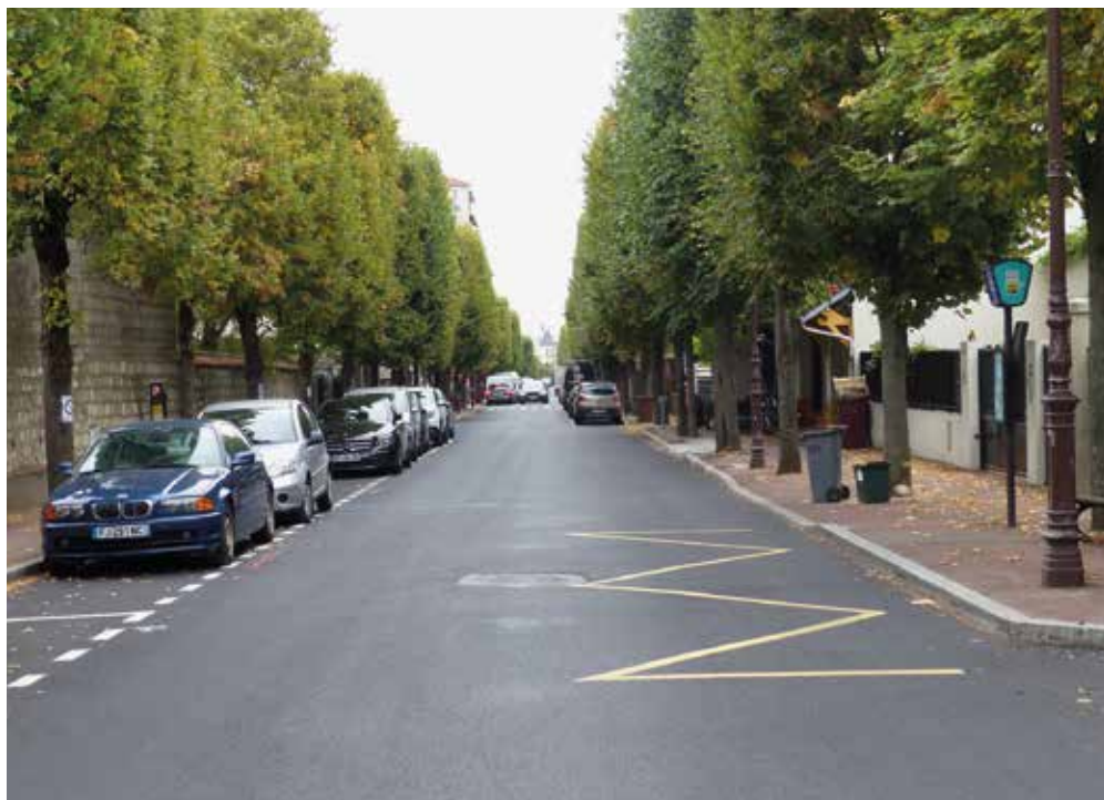
Avenue du Maréchal-Foch.
