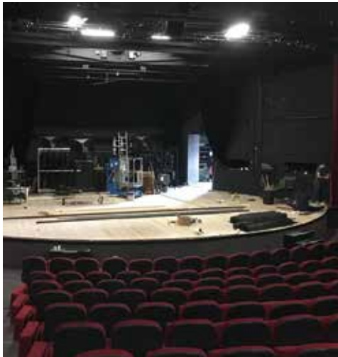
Travaux sur la scène des 3 Pierrots.
