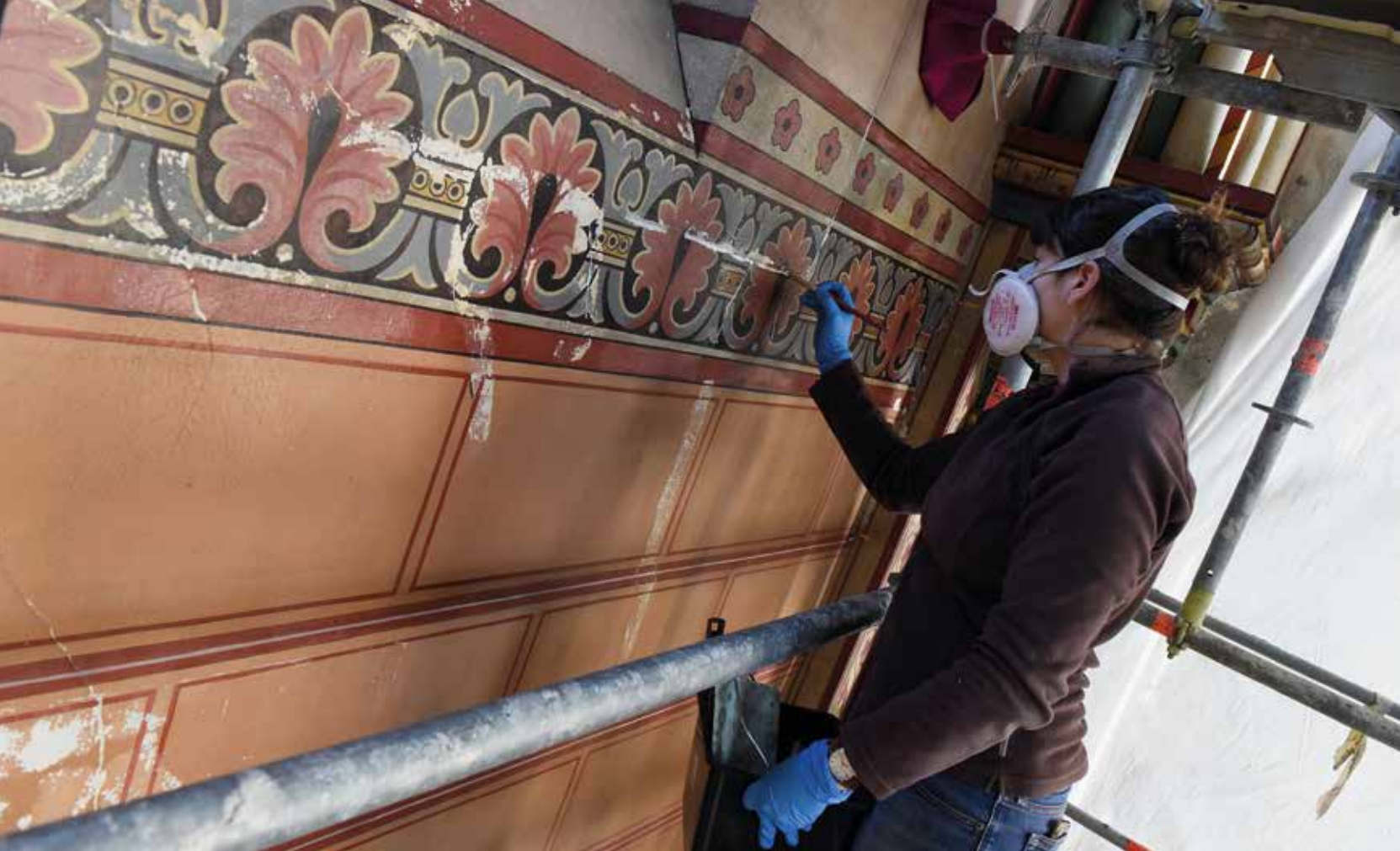
Le chantier en cours de la restauration des peintures du chœur de l'église.
