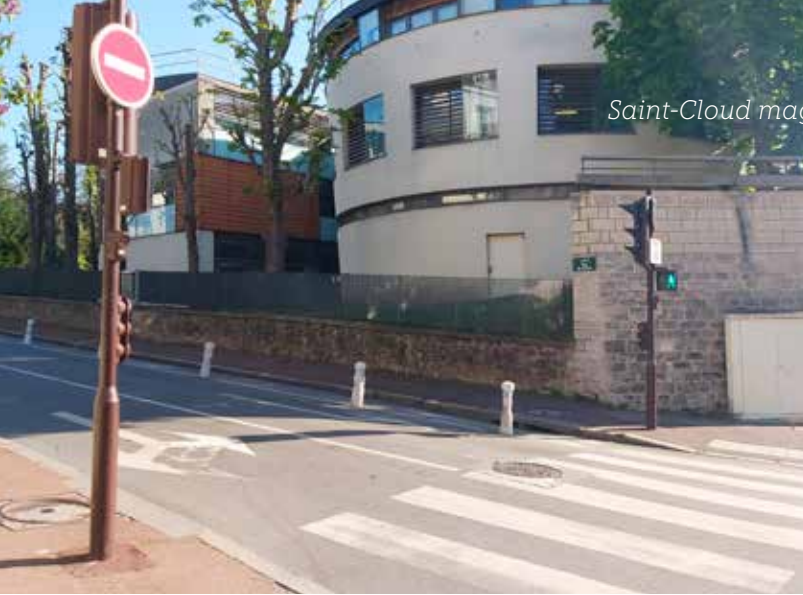
À Saint-Cloud, plusieurs carrefours avec passages piétons sont équipés d'un dispositif sonore*.
