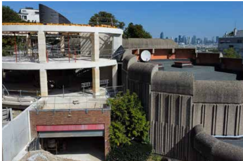
Le chantier des 3 Pierrots (été 2023)
