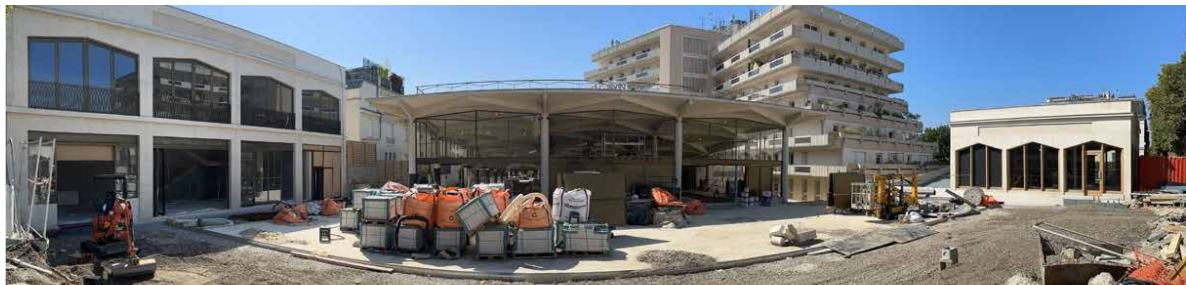
Les travaux sur le site des Avelines (été 2023)
