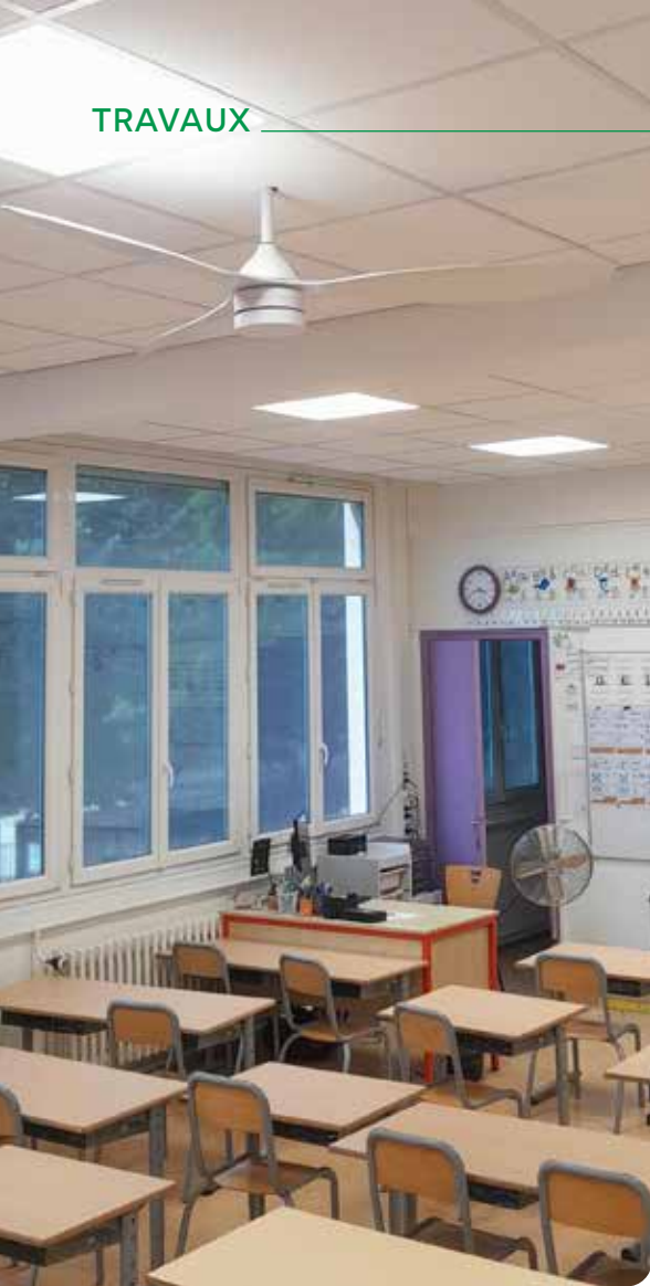
Installation de ventilateurs de plafond à l'école élémentaire du Val d'or.
