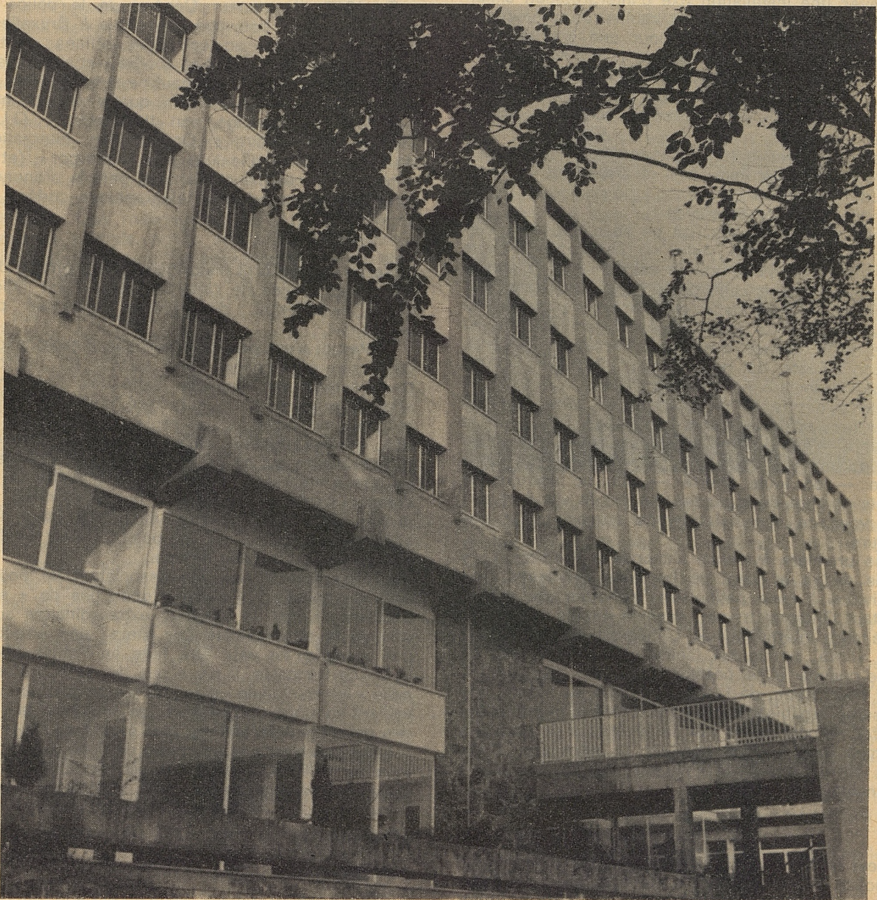
Vue d'ensemble du bâtiment, 26, rue Armengaud
