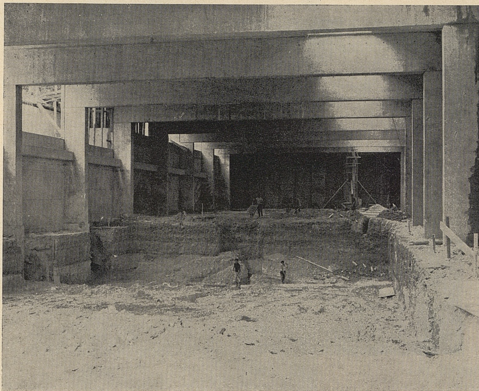
(Etat des travaux au 31 août)
