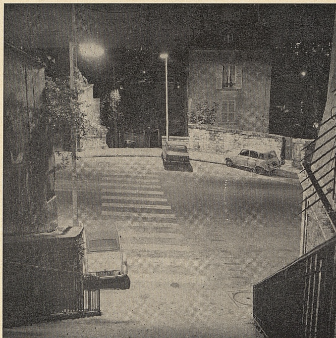
Passage protégé éclairé aux vapeurs de sodium
