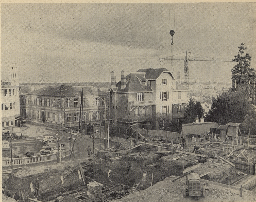
Chantier nouvelle école maternelle
