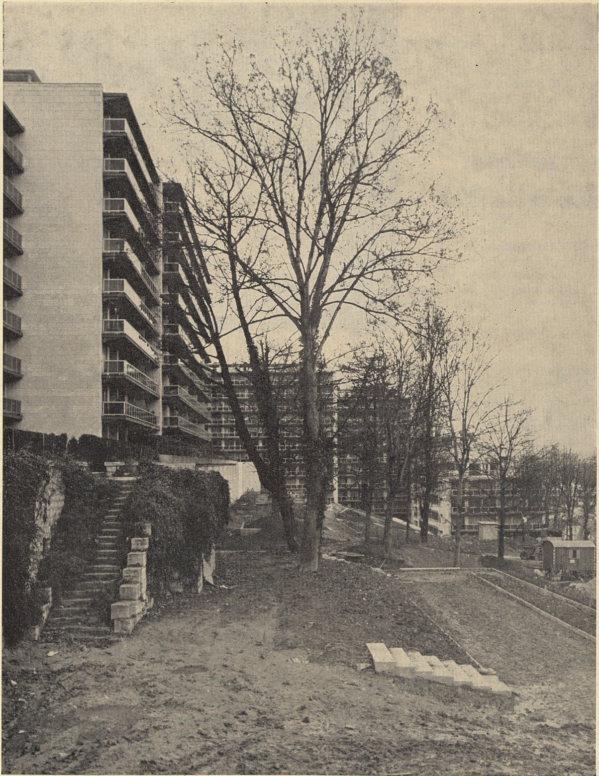
Les travaux en cours d'aménagement du mail avenue André-Chevillon, promenade publique
