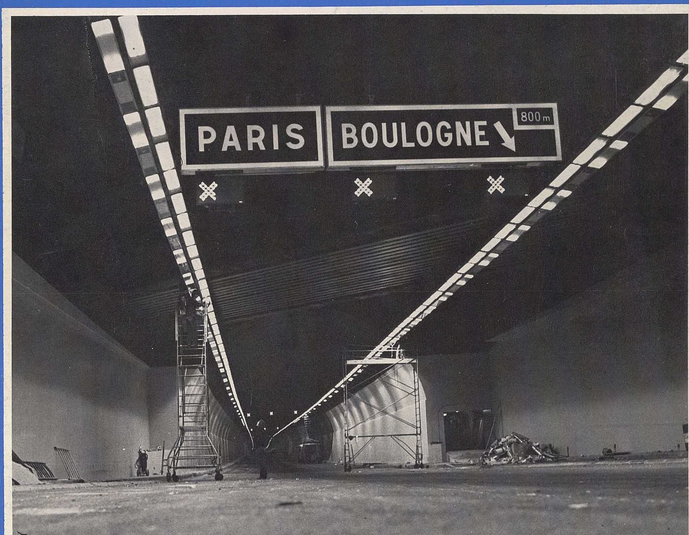
DOUBLEMENT DU TUNNEL DE L'AUTOROUTE DE L'OUEST . FINITION
