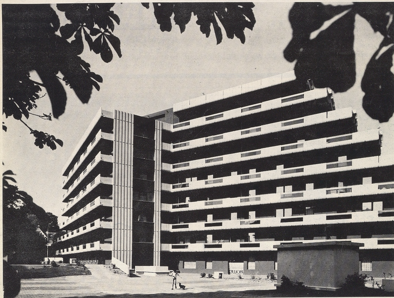
IMMEUBLE H.L.M. MONTRETOUT, 38-40, BOULEVARD DE LA REPUBLIQUE
