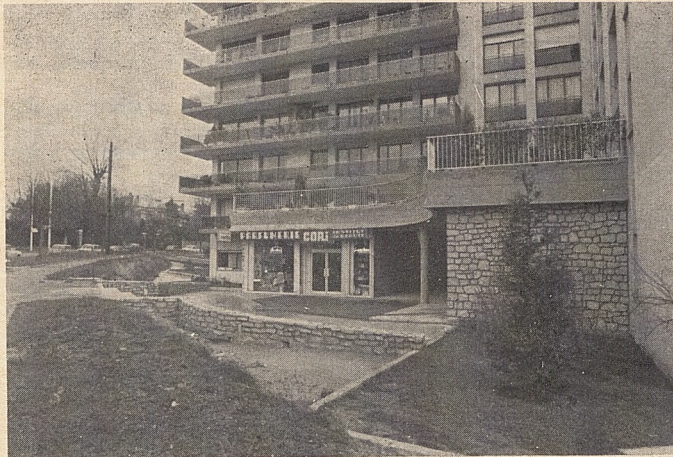
Cheminement piétonnier, boulevard de la République (Photo Leroy)
