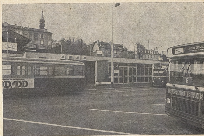
La gare S.N.C.F. et routière du Pont de Saint-Cloud
