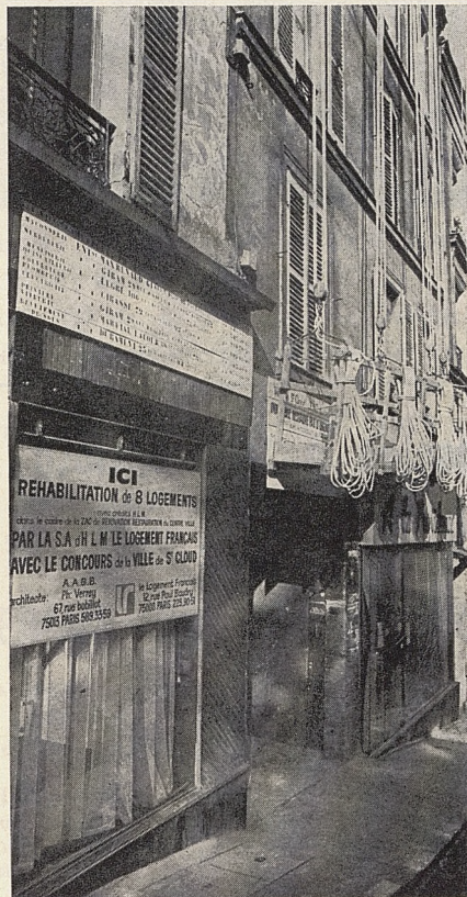
Immeubles des 18 et 20, rue Royale en cours de restauration
