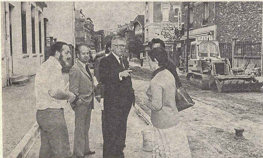
De vastes travaux de réfection des voies ont également été entrepris à l'extérieur de l'Ecole des Coteaux
