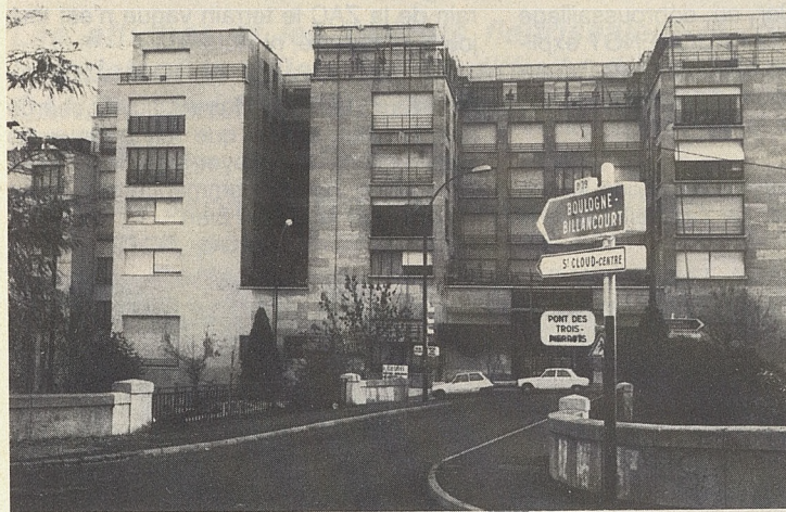
Une nouvelle signalisation a été installée aux abords du pont des Trois-Pierrots et de la rue Traversière.
