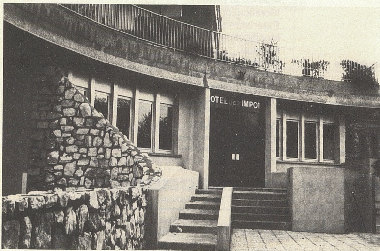
Le Centre des Impôts et la Recette Principale des Impôts, 20, Boulevard de la République : une initiative très bien ressentie par la population.
