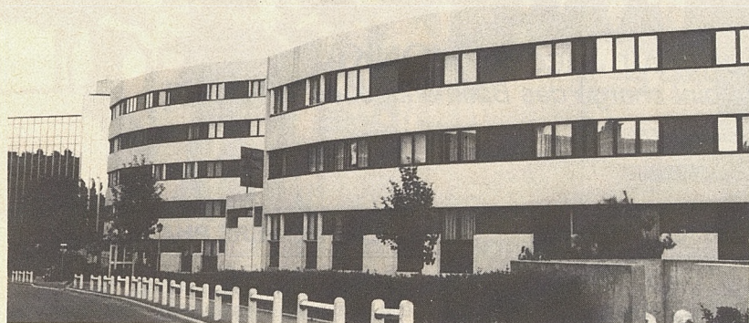
Les immeubles H.L.M. de la Fouilleuse
