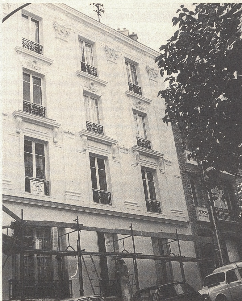
La restauration des façades continue : ici, l'immeuble du 33, rue Royale.
