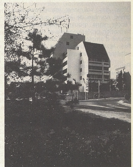
27, rue Dailly Premier immeuble de la rénovation.
