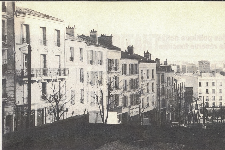
Immeubles de la rue Royale rénovés.
