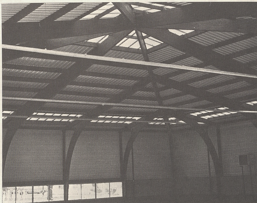
L'élégante charpente en lamé lé-collé du Centre Sportif Marcel Dassault Val d'Or
