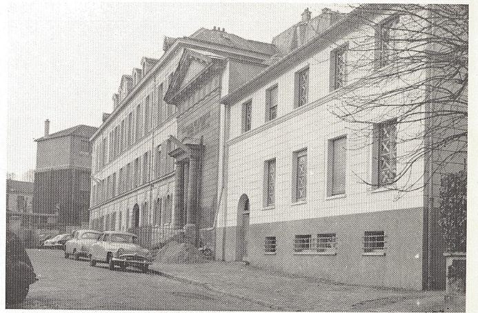
... un bâtiment a été construit pour l'agrandissement de l'hôpital (1 re tranche).
