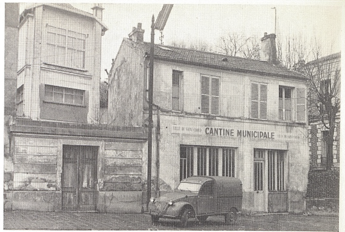
Sur l'emplacement de l'ancienne cantine municipale désaffectée..
