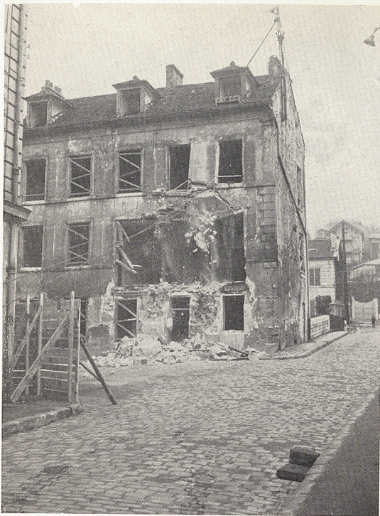
Démolition d'un immeuble menaçant ruines, 9, rue du Nord.
