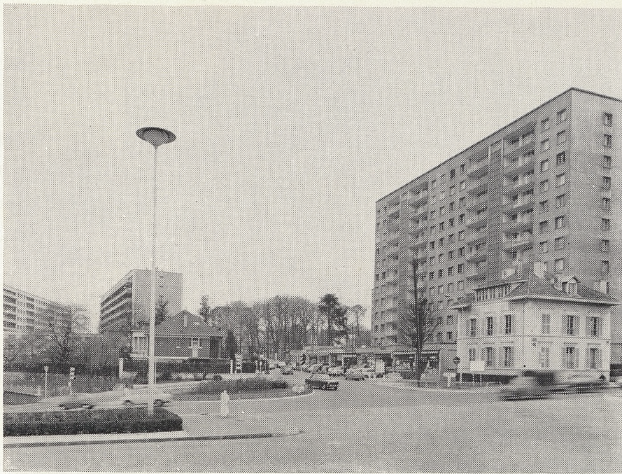
RÉNOVATION de la voirie : aménagement du carrefour Washington...
