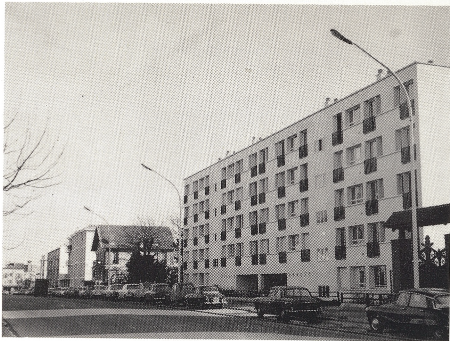
MODERNISATION de la voirie : élargissement de la rue Pasteur
