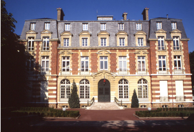
Vue du collège Émile-Verhaeren, ancienne villa Mennet, construite vers 1890, Saint-Cloud.
